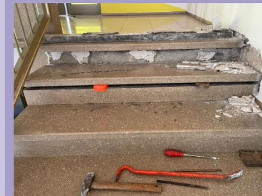
Proberückbau des Treppenstufen-Belags und Darstellung des verwendeten Werkzeuges
